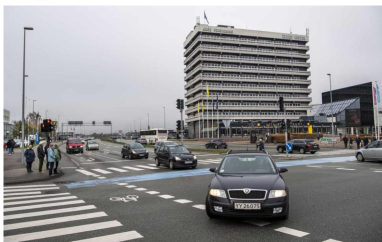
Med Zleep-hotellet skyder Viby Torv allerede i vejret. I planerne for torvet indgår et ønske om at bygge fire etager på hotellet og opføre et nyt højt hus lige ovre på den anden side af Viby Ringvej. Foto: Axel Schütt
